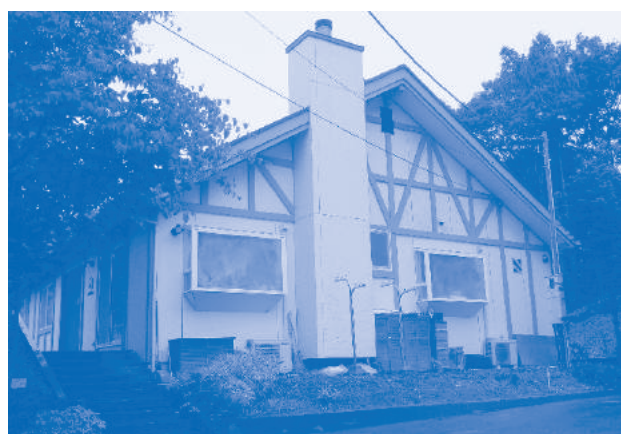
パンダハウス外観
